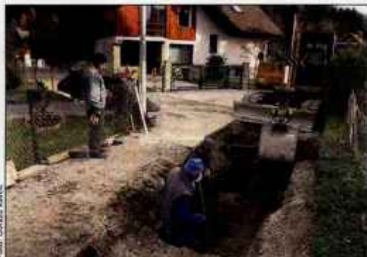
Ob gradnji kanalizacije krajanje zahtevajo obvozno cesto.
