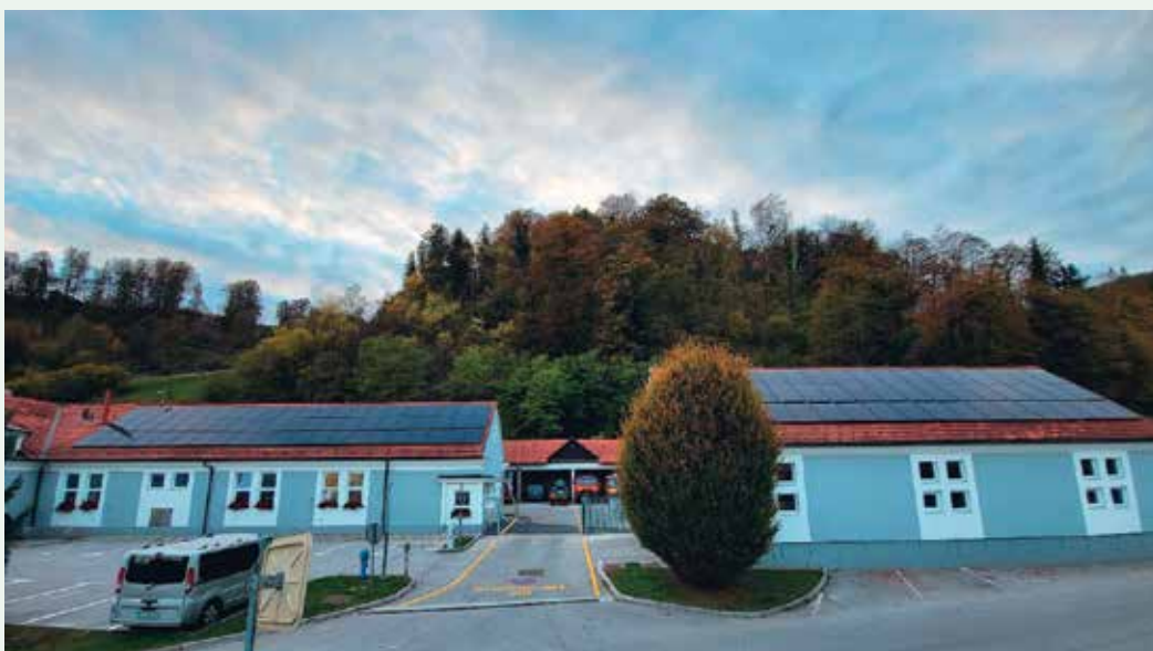
Mala fotonapetostna elektrarna Komunala Laško
