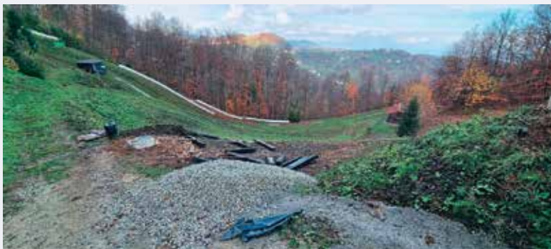
Izgradnja vzpenjače in planiranje za pripravo smučišča
