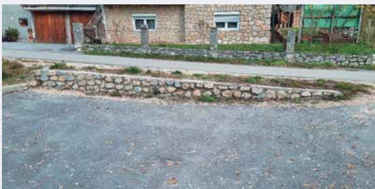
Kamniti oporni zid
