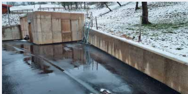
AB oporni zid s konstrukcijo garaže in asfaltirano transportno potjo
