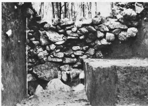
Sl. 9: Kunkel pod Vrhtrebnjem, sonda 1. Zunanja fronta 2. zidu, čelni pogled.
