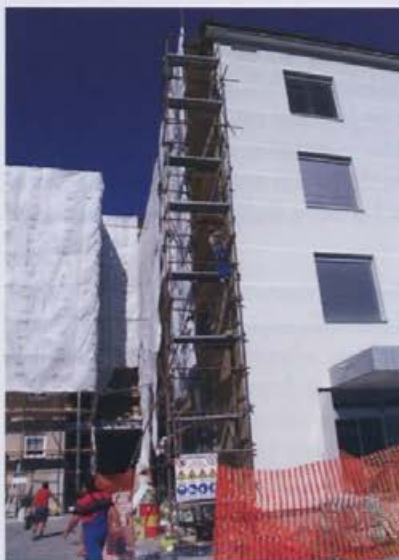
Stavba Alpina med prenovno
