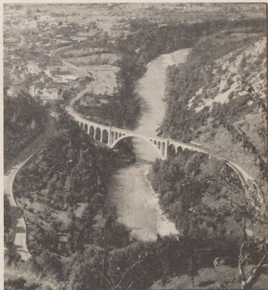
Slika 3. Pri Solkanu se čez Sočo pne v enem oboku lep železniški most.
