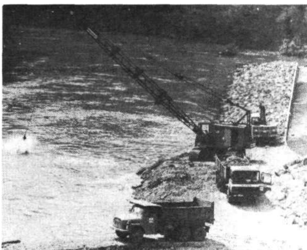
HE Mavčiče: iz nekdanjega gradbenega nasipa in iz struge pod jezom zdaj odvažajo na druga mesta in z njim urejajo okolico. Na desnem robu fotografije je kanal, predviden za drsitišče. Strokovnjaki upajo, da se bodo ribe prilagodile razmeram v njem, saj bi to pomagalo obnoviti življenje v Savi. (Foto: Goran Rovin)
