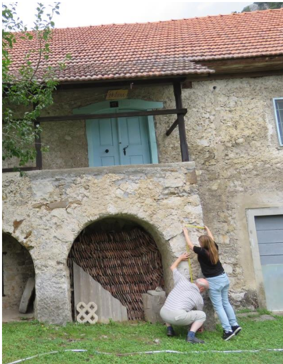
Slika 46: Arhitekturni posnetki starih stavb so naša dejavnost že skoraj deset let. Hiša pri Petrovih, s t.i. baladurjem - priča primorske gradbene tradicije, Zagolik, 2016
