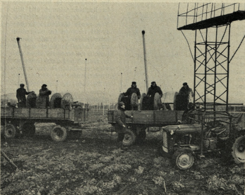
Napeljava žične mreže iz žice izolirane s PVC
