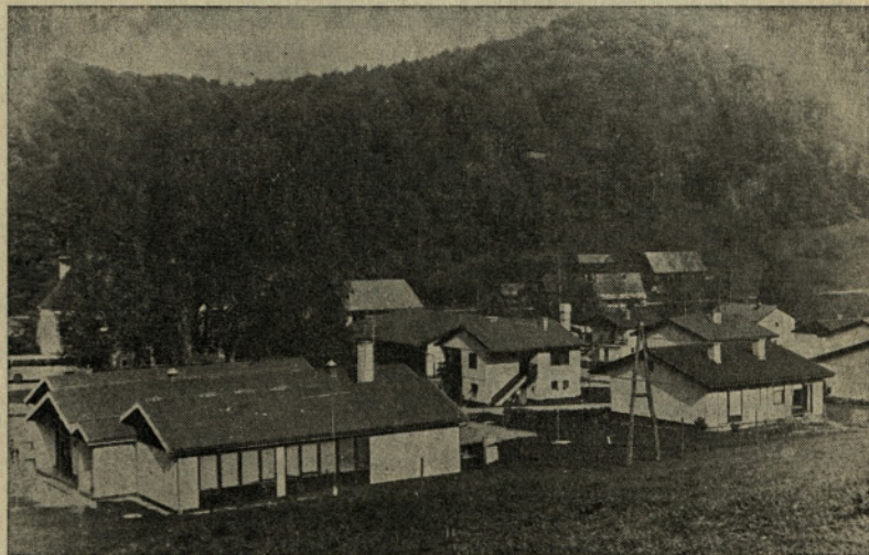
Loka pri Žusmu urejena po potresu.
