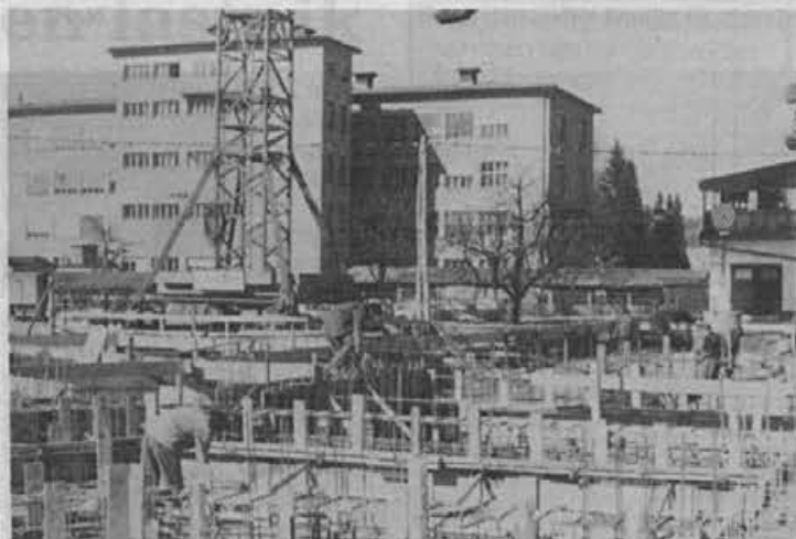
Konzorcij za gradnjo »Pri Matic« je očitno uspešno zastavil svoje delo, saj je gradnja že stekla
