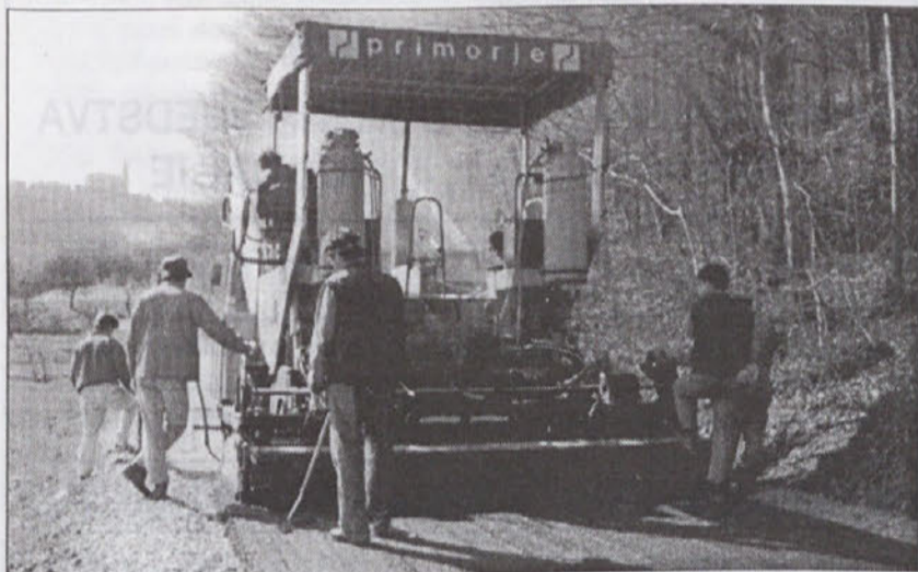
Asfaltiranje ceste pri Premskem mostu
