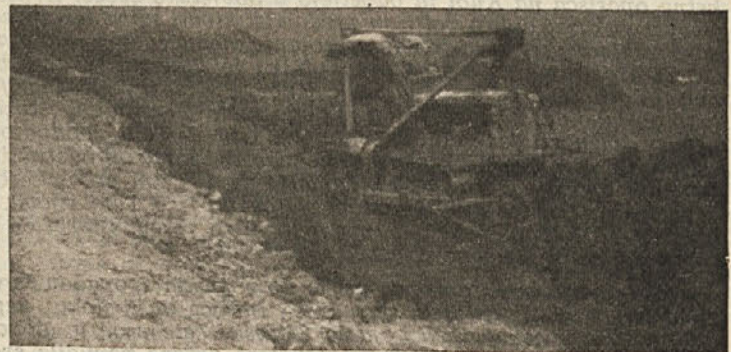
Nova cesta dobiva jasnejše obrise tudi na doljenjevaškem polju, kjer so jo že zakoličili. Delavci že pripravljajo teren za usek na Jasnici, po polju pa je pred kratkim buldožer obcesti že odstranil vrhnje plasti zemlje, kjer bo šla nova cesta
