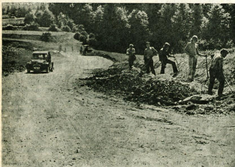
Gradbena dela na cesti SELO—VRHPOLJE hitro napreduje tako, da bo trasa kmalu pripravljena za polaganje asfalta
