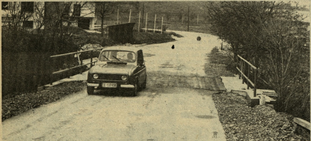
V prvi polovici novembra so se vozniki že lahko zapeljali po obnovljenem mostu na cesti Griže—Prebold. Dela so bila opravljena v kratkem času in to po zaslugi, kot pravijo na krajevni skupnosti, štirih upokojencev, ki so delali cele dneve. Poleg tega pa je bila takšna obnova znatno cenejša, zanjo so le odšteli nekaj nad 200 tisoč dinarjev.
