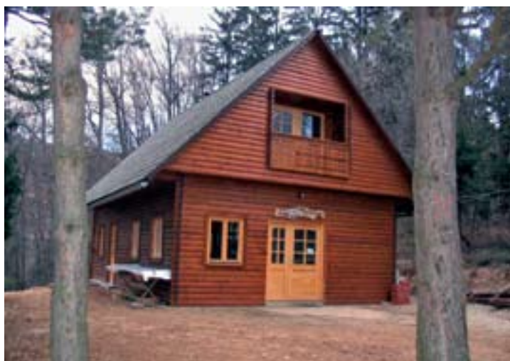
Na novo zgrajeni dom Planinskega društva Blagajana na Ravneku pod Grmado
