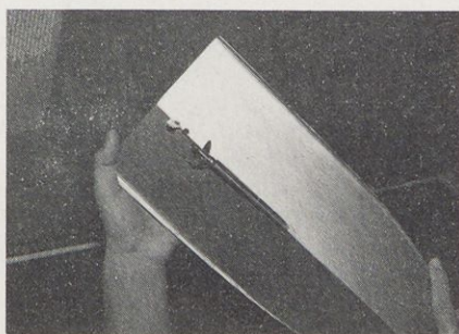
Posnetek spodnje strani čolna, na katerem so vidni stranski vzdolžni kanali.
