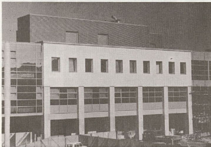
Prizidek pošte je bil dograjen v letu 1992. V njem od pomladi dalje že obratuje nova telefonska centrala.
