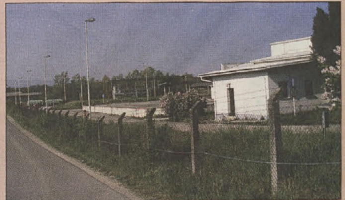
Opuščeno Petrolovo skladišče
