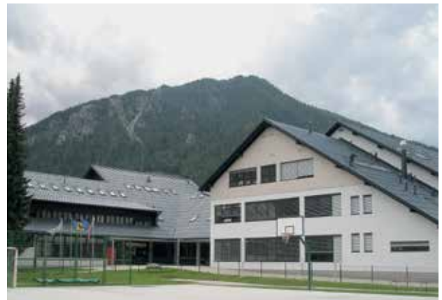
Slika 2: Osnovna šola Josipa Vandota Kranjska Gora
