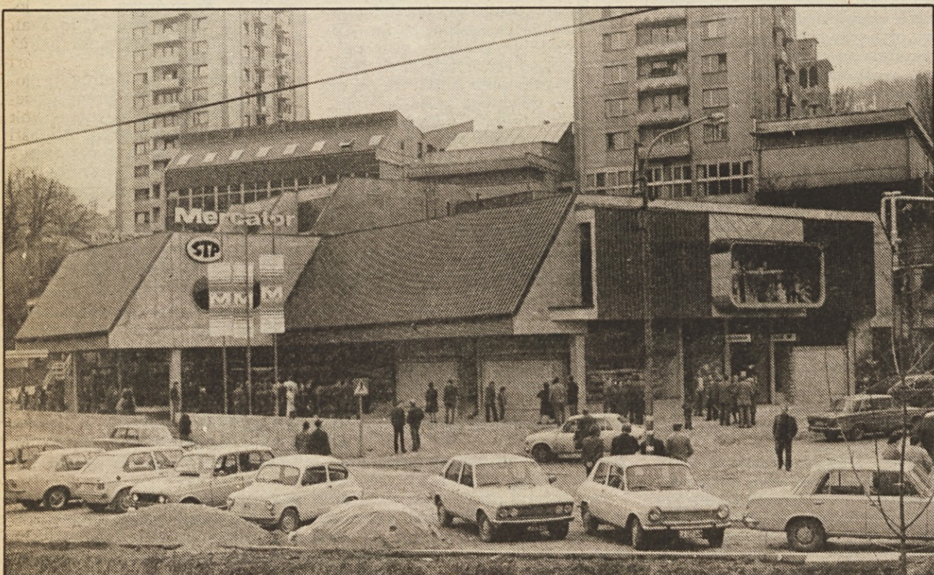
Novi del Blagovnice. Levo zadaj se skriva stari del.
