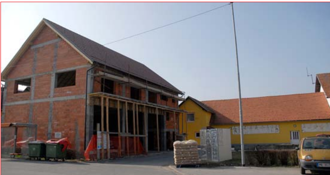
Poleg doma krajanov na Turnišču trenutno poteka gradnja novega gasilskega doma.
