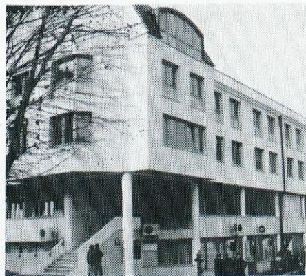
Poslovno - stanovanjski objekt s PTT enoto, osnova za nove telefonske priključke v občini
