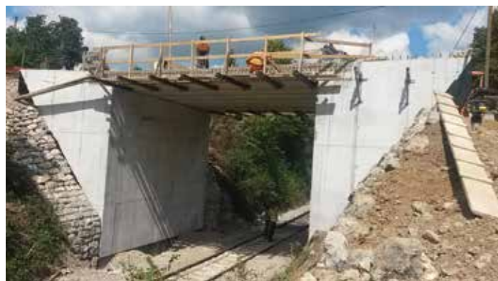
IZGRADNJA NOVEGA NADVOZA NAD ŽELEZNIŠKO PROGO V DOLNJIH RETJAH.
