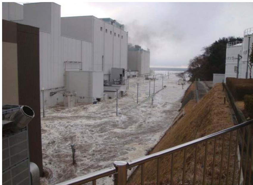
Slika 3: Poplava v jedrski elektrarni Fukušima 1, ki jo je povzročil cunami. Vir: VGB Power Tech.
