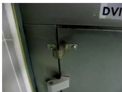
Slika 5: Ozemljeni tečajji kril jaškovnih vrat malega tovornega dvigala
