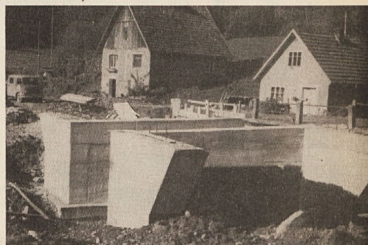
Gradnja mostu na cesti Mitroviči – Osilnica
