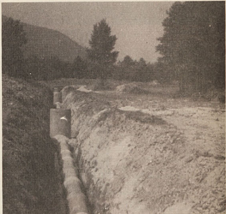
Izgradnja kanalizacije Stara cerkev – Slovenska vas – Kočevje
