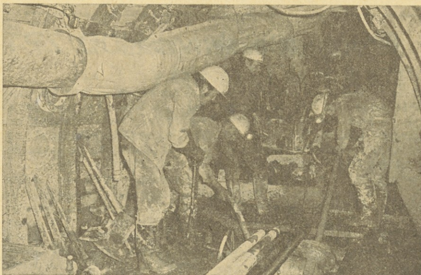
Jože Zabrložnik, Franc Kellner in Stanko Dobršek pri izdelovanju proge v dolomitu v jami Ojstro. Dela izvaja TOZD RIG DO RGD. (Foto A. Bregant)
