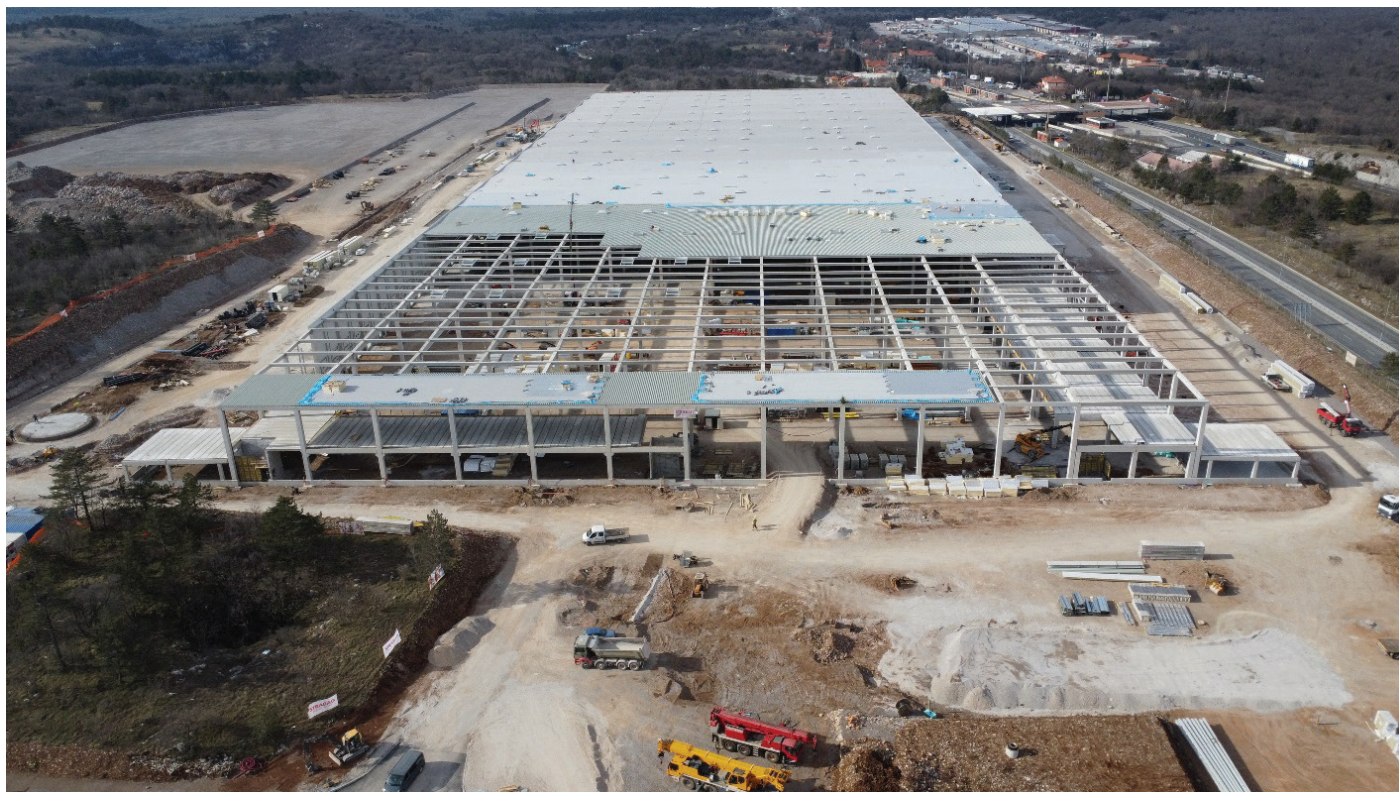
Slika 1. Logistični center TEDI Sežana v izgradnji.
