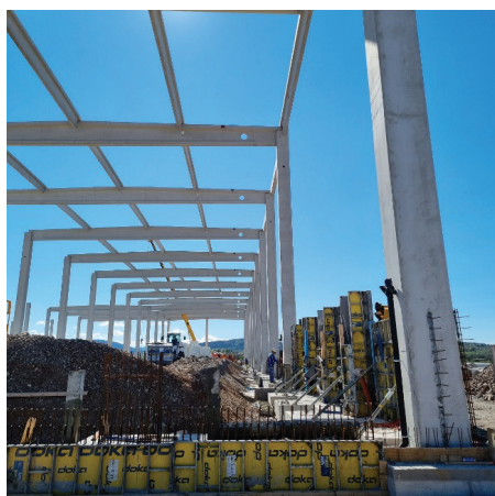
Slika 7. Izvedba parapetnih zidov okoli objekta.
