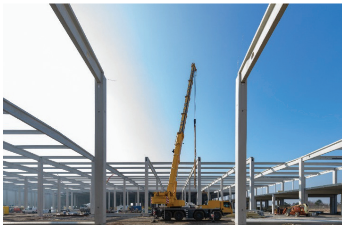
Slika 4 in 5. Montaža armiranobetonske konstrukcije.
