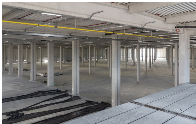
Slika 12. Izvedba inštalaterskih del.
