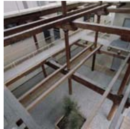
Slika 4: Dostop do stanovanj je prek vitkih armiranobetonskih mostov. The accesses to the flats run on slender reinforced concrete bridges.
