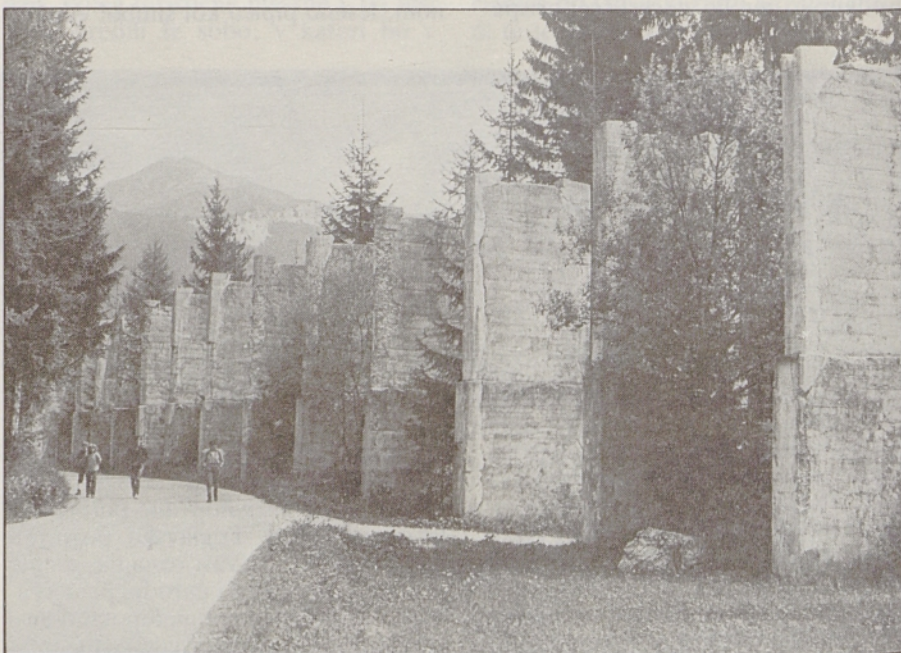
Ostanki vodovodne napeljave nekdanje cementarne, ki je delovala v Mojstrani.
