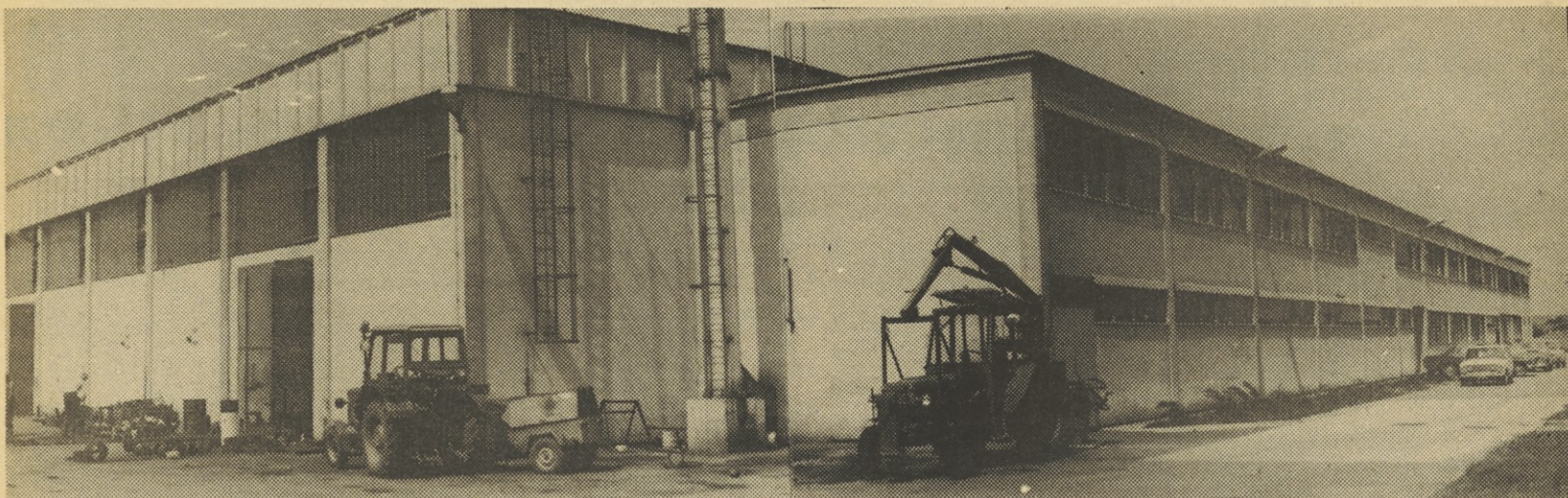
Prostori TOZD Montaža v Mariboru
