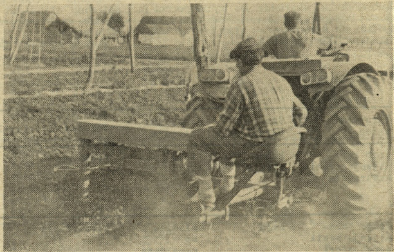
Češki obrezovalnik pravtako bočni, opremljen s hidravličnim cilindrom za odmikanje stroja pri drogovih. Hidravlika je ročno krmiljena
