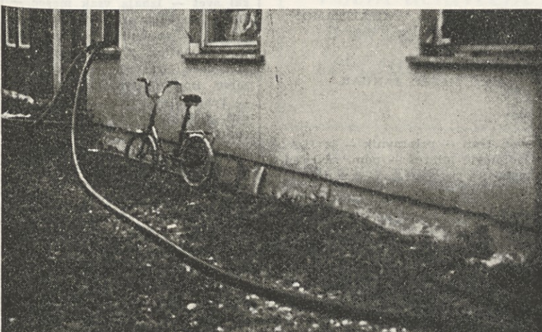
Preizkušnja ogrevanja samskega doma z odpadnim kondenzatom iz toplotarne je uspela. Potrebno je samo še dela dokončati
