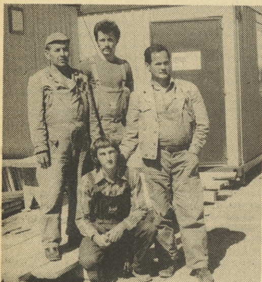
Monterji TOZD Elektromontaža. Od leve: Nikola Terzić, Bojan Jašovec, Čedomir Žunić, Branko Venčec (čepi)
