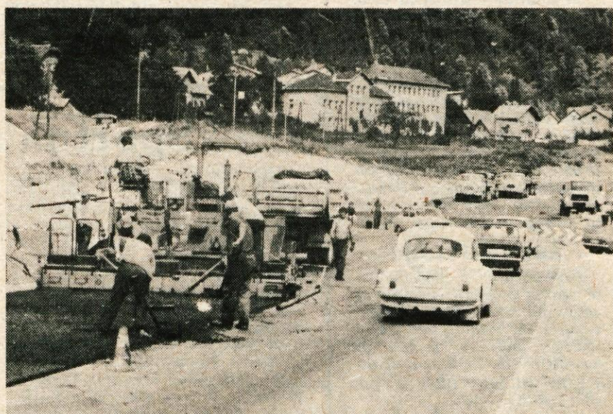
Prejšnji teden so delavci Cestnega podjetja Kranj položili še plast drobnega asfalta na novem delu ceste od potoka Bele na Koroški Beli do Javornika, kjer se novi del priključi stari cesti. — B. B.
