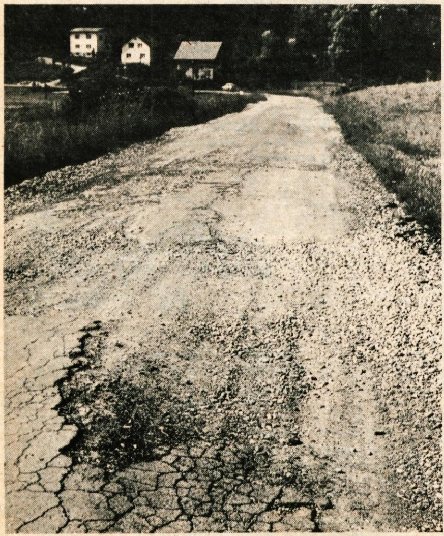
Medtem ko je cesta od Tenetiš do začetka Gorič zasilno zakrpana, pa je odsek od Gorič do Golnika, od koder je fotografija, izredno slab. Asfaltna prevleka je zaradi vsakdanjega prometa, še posebno pa zaradi tovornjakov, ki so vozili gradbeni material in asfalt na novo cesto Golnik—Senično, skoraj popolnoma uničena. Vožnja po takšni cesti ni prijetna. Še posebno za težke bolnike, ki jih reševalni avtomobili vsak dan prevažajo na Golnik ali obratno! (jk) — Foto: F. Perdan
