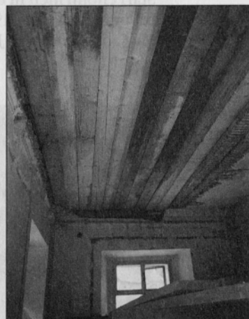
Obnova povešenega stropa.
