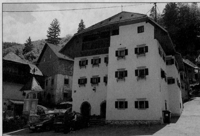
Stavba Kropa št. 13, stanje po obnovi leta 2001.
