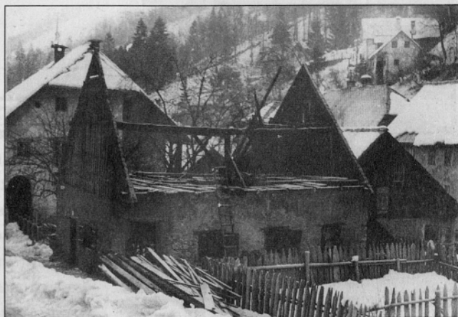
Obnova ostrešja vigenjca Vice leta 1971. Obnova je tekla pod nadzorstvom Zavoda za spomeniško varstvo Kranj.
