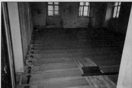
Sanacija poda v osrednji sobi. Kovinski nosilci.
