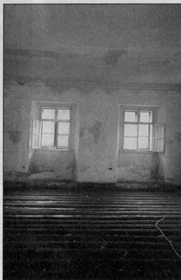
Sanacija poda v osrednji sobi. Zaščitni premaz.
