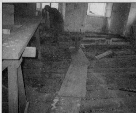
Sanacija poda v osrednji sobi.
