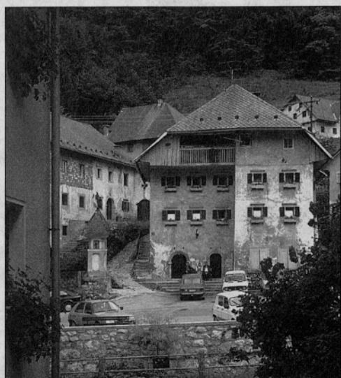
Stavba Kropa št. 13, stanje pred obnovo.
