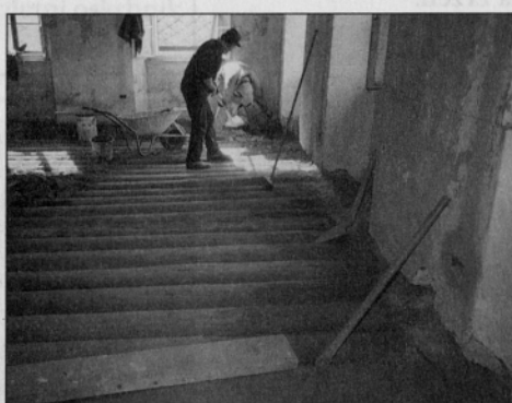
Sanacija poda v osrednji sobi. Leseni nosilci so bili ponekod že trhli. Gobe ni bilo.
