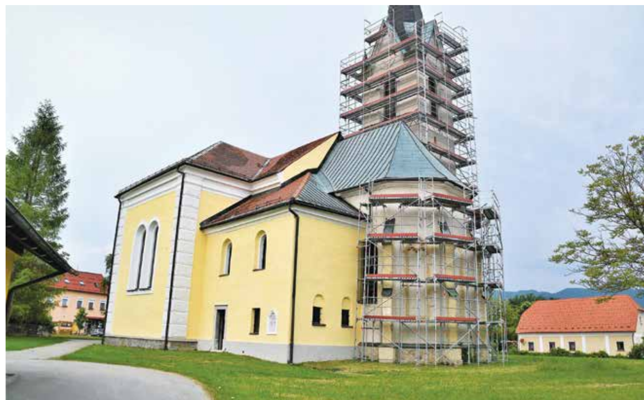
Na taborski cerkvi sv. Jurija se končujejo dela fasade na zvoniku in prezbiteriju.
