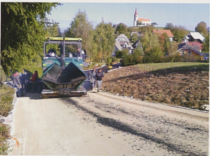
Letos se bo asfaltiralo še 500 m ceste Planinska vas-Jevše
