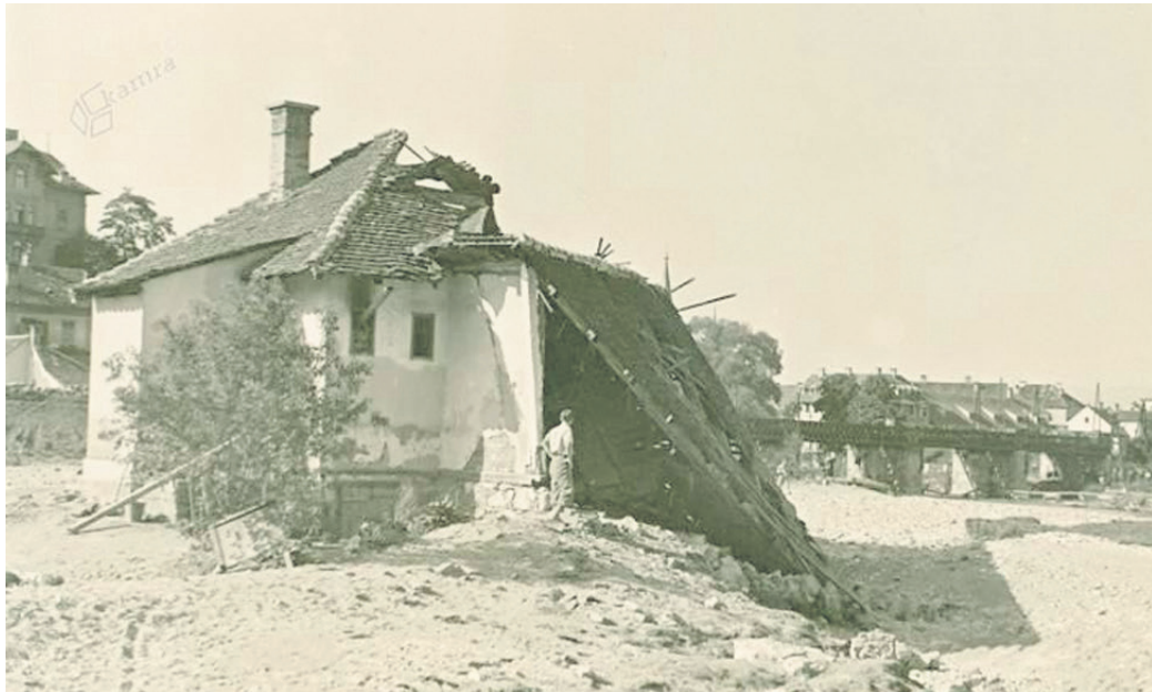
V Celju, ob ovinku Savinje na Bregu, je bila postavljena tako imenovana izolirna bolnica, po domače »kolera špital«. Stavba je bila v tridesetih letih prejšnjega stoletja, ko jo je močno poškodovala poplava, porušena. (Foto: www.kamra.si)
