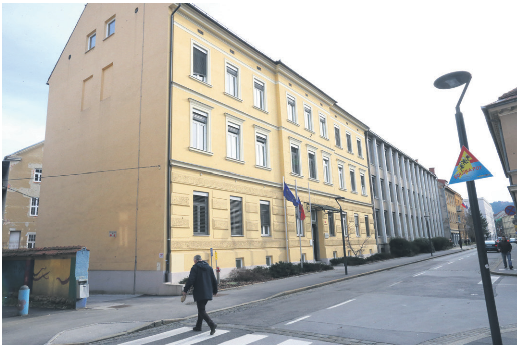
Poslopje nekdanje srednje ekonomske šole v Celju (v ozadju je Kajuhov dom) bo po dolgoletnih pogajanjih z ministrstvom za izobraževanje vendarle pripadlo Mestni občini Celje.
