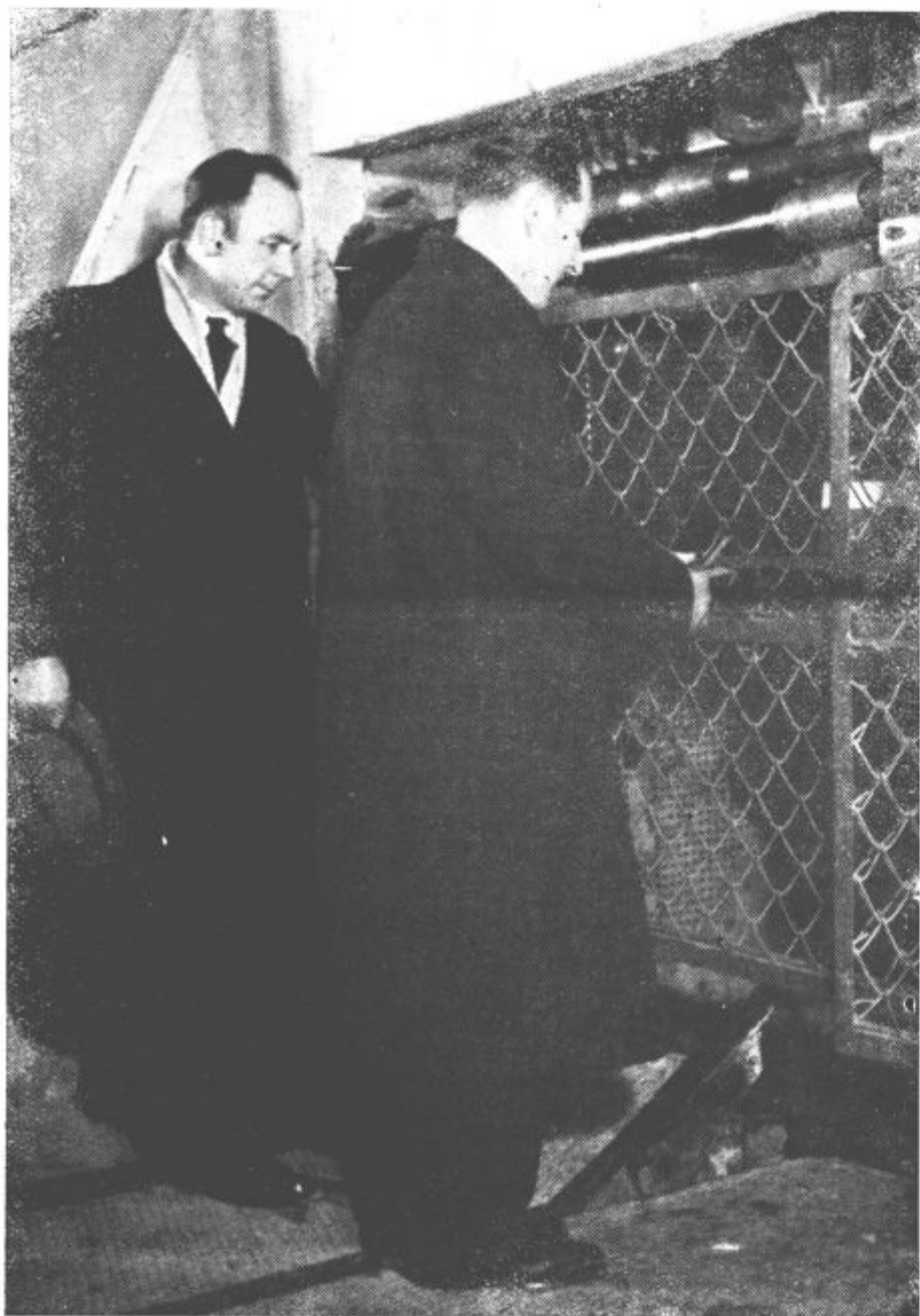
Levo: Direktor rudnika tov. Nesli Zgank je s prerezanjem zaporne vrvice odprl pot iz novega jaška
