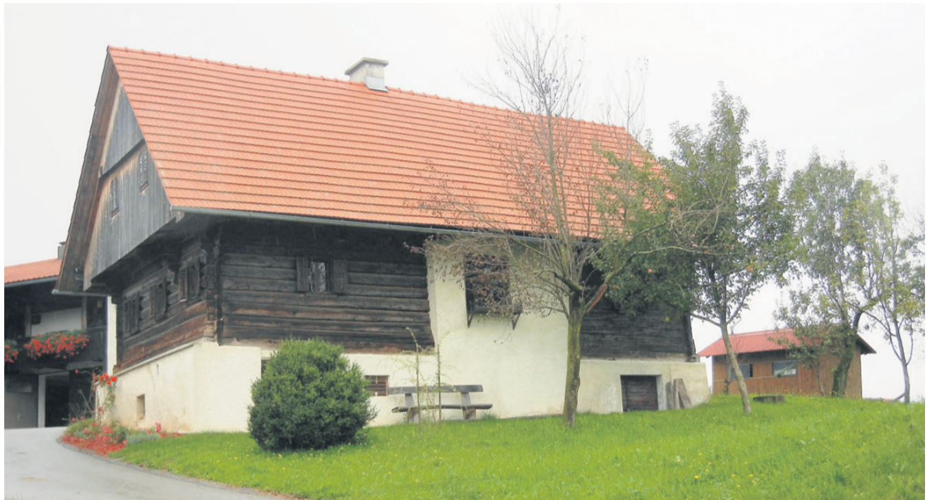
Rezarjeva hiša, zgrajena leta 1806, je na obrobju Grajske vasi. Danes je še vedno lepo ohranjena. Kljub temu da danes v njej nihče več ne prebiva, še vedno služi svojemu namenu. V njej »delajo« kolone in shranjujejo pridelke ter v stari krušni peči pečejo kruh.
