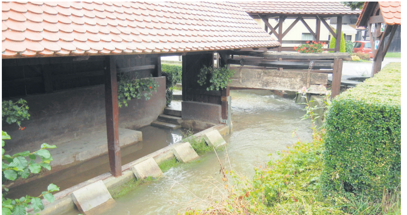
Posebna znamenitost Grajske vasi, ki leži na sotočju potokov Reke in Konjščice, je vaško perišče, ki je bilo zgrajeno kmalu po drugi svetovni vojni ob potoku Reka. Po pojavu pralnih strojev je perišče začelo počasi propadati. Leta 1999 so ga Grajani v celoti obnovili.
