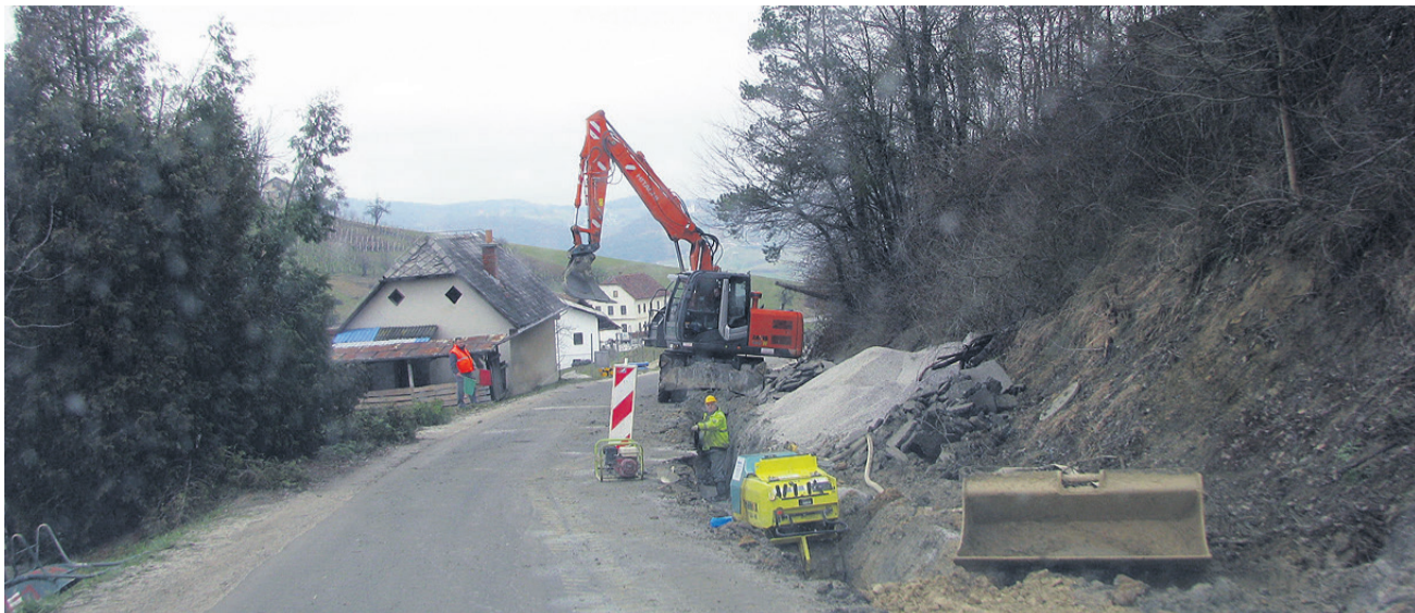
Projekt Oskrba s pitno vodo se končuje. V Občini Šmarje pri Jelšah so za razumevanje in strpnost hvaležni lastnikom zemljišč in uporabnikom cest, saj je bil med gradnjo vodovodnega omrežja pogosto oviran promet. Fotografija prikazuje gradnjo vodovodnega omrežja v kraju Sveti Štefan.
