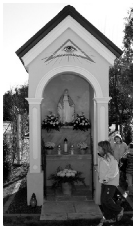
Obnovljena Marijina kapelica v Lučah.
