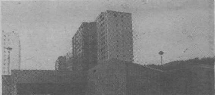
Pod Litijsko cesto je sredi Štepanjskega naselja zrasel varen podhod za pešce. (Foto: HVASTIJA)
