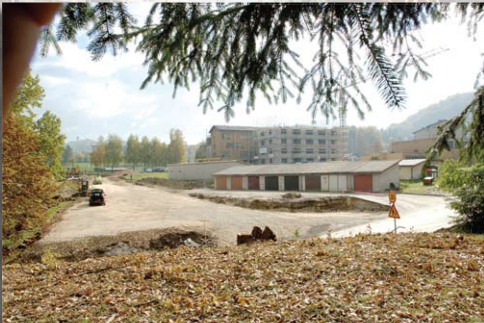
Dom Lipa in nadvoz Lipa v izgradnji foto: Aleš Korošec
