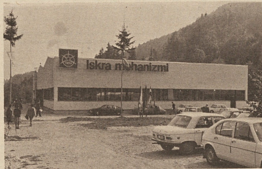
TOZD Mehanizmi v Lipnici je pretekle dni slavila svojo 20-letnico. Na sliki: novi proizvodni objekt. O tem pišemo na 4. in 5. strani.
