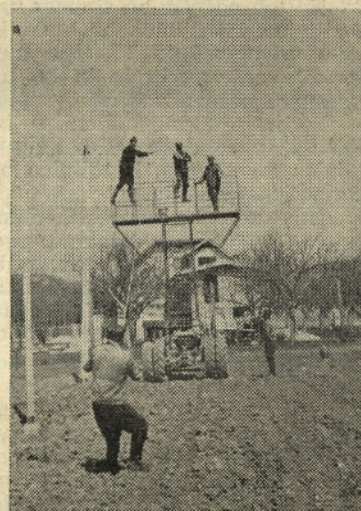
Nategovanje vodilnih jeklenih vrvi ali po domače »laufarjev« v žičnici pod Zg. Grušovljami
