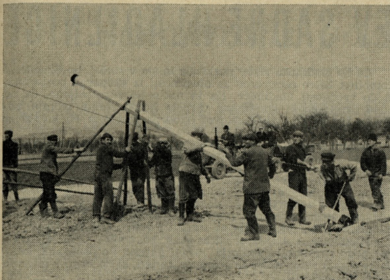
»Rusova« skupina dokončuje postavljanje velike betonke v Trnavi
