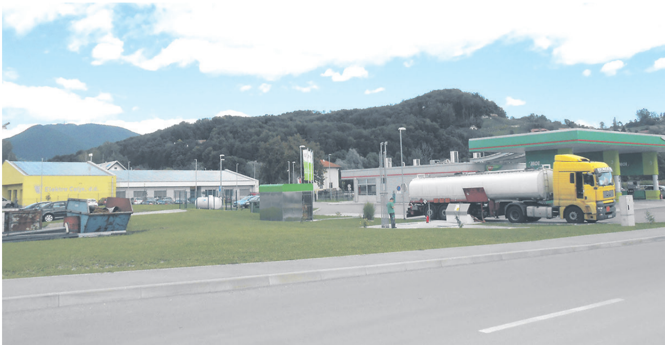
Vodja oddelka za okolje in prostor na Občini Šmarje pri Jelšah Peter Planinšek je povedal, da so podjetniki infrastrukturo, lego in dostopnost obrtno-poslovne cone v Mestinju ocenili kot odlično za razvoj njihove dejavnosti. Čistilna naprava in kanalizacijski sistem bosta še doprinesla h komunalni opremljenosti območja.
