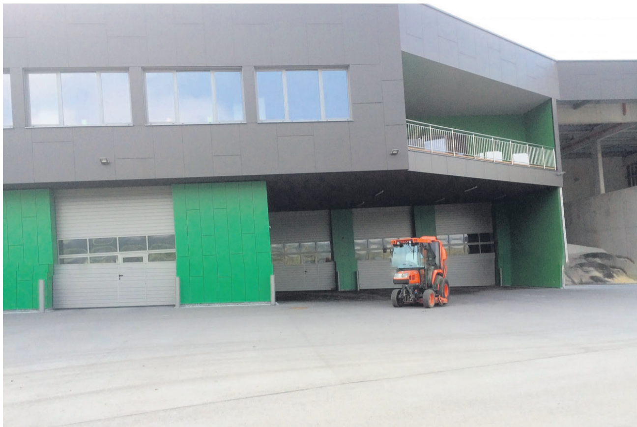
V novi poslovni stavbi imajo boljše pogoje za hrambo in vzdrževanje skoraj 50 vozil za različne namene (tovornjaki, bagerji, valjarji ...).
