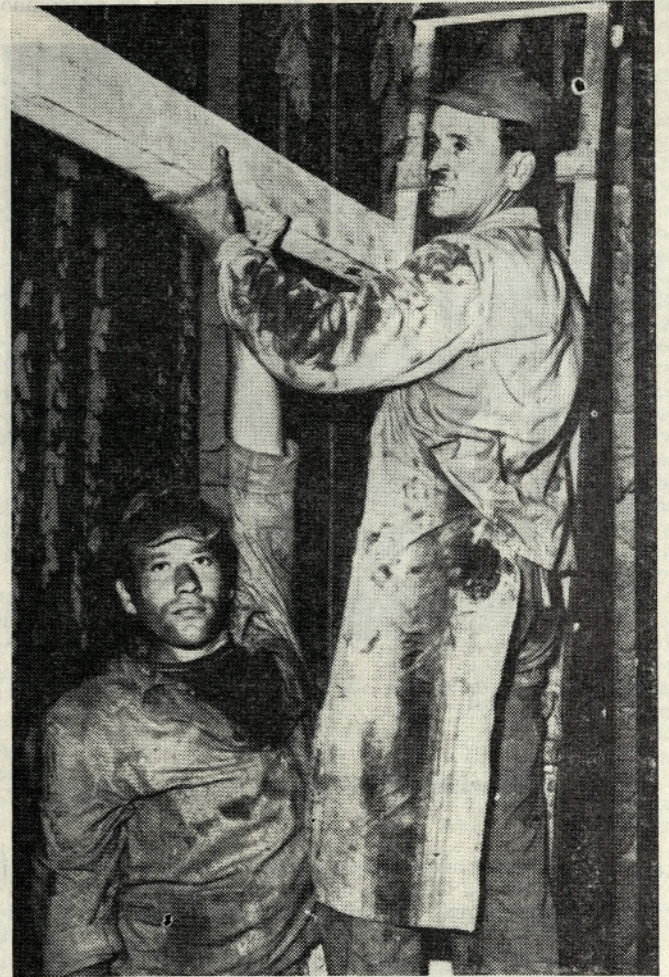
Postavljanje odrov v notranjosti kotla
