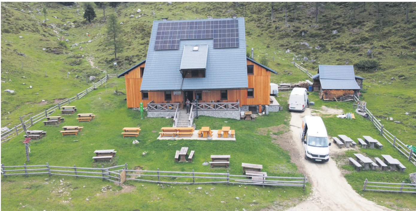
Uspešno na razpisu je bilo tudi Planinsko društvo Luče. Pridobilo je sto tisoč evrov nepovratnih sredstev za energetske sanacije Koče na Loki na vzhodnem pobočju pod Raduhe, in sicer tik nad gozdno mejo. (Foto: PD Luče)
