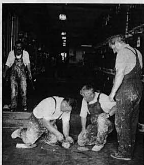
Tla v oddelku termoplastov so bila na nekaterih mestih že zelo dotrajana in potrebna obnove. To delo so opravili med kolektivnim dopustom
