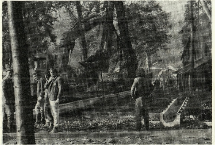
Cev je pripravljena za polaganje pod strugo Save
